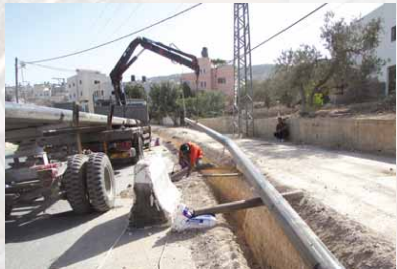
تزويد المياه لمنطقة طوباس / تياسير (استبدال خط مياه عقابا)
