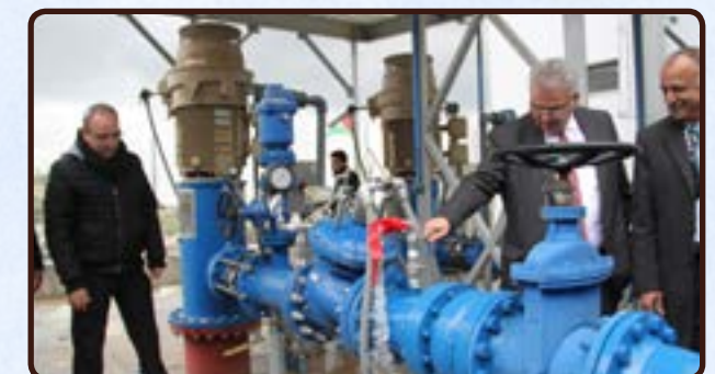
وضع حجر الأساس لمشروع محطة معالجة المياه العادمة - سلفيت (20 تشرين ثاني 2019)
