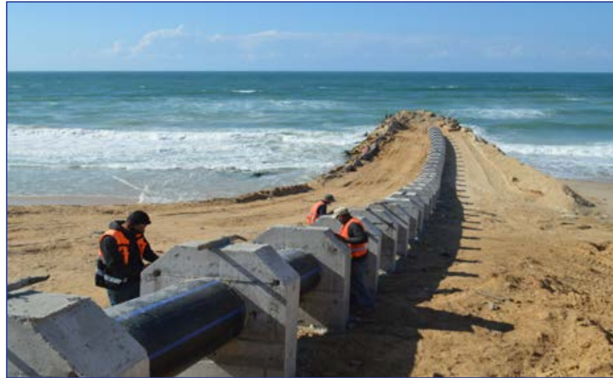
توسعة محطة تحلية الجنوب - خط مياه البحر
