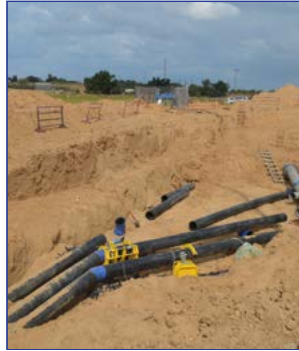
تمديد شبكة المياه الإضافية شرق المغازي
